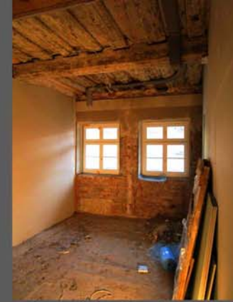
während der Sanierung
